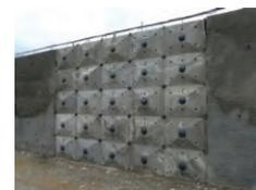
Ouvrage démonstrateur du nouveau concept de paroi clouée AD/OC (auto drainante-optimisée en carbone). Travaux de recherche en collaboration avec l'entreprise GTS et le laboratoire IFSTAR de Lyon
